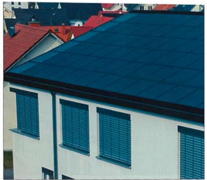
Von „Flickenteppich“ keine Spur mehr: Das linke Dach ist komplett mit Photovoltaikmodulen bestückt. Auf dem Neubau rechts sind PV-Module mit 9,36 Kilowattpeak Leistung sowie Solarkollektoren mit einer thermischen Leistung von 3,15 Kilowatt (links im Dach) integriert.
