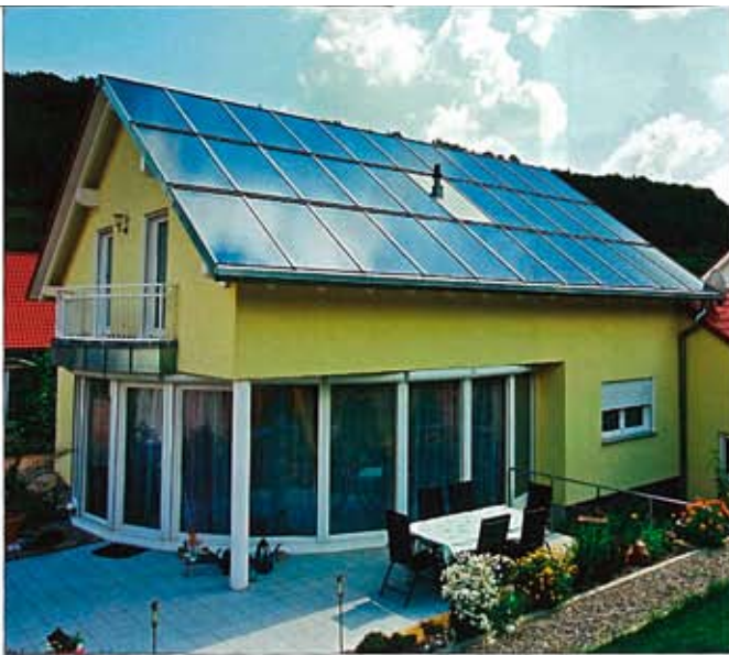
Von „Flickenteppich“ keine Spur mehr: Das linke Dach ist komplett mit Photovoltaikmodulen bestückt. Auf dem Neubau rechts sind PV-Module mit 9,36 Kilowattpeak Leistung sowie Solarkollektoren mit einer thermischen Leistung von 3,15 Kilowatt (links im Dach) integriert.
