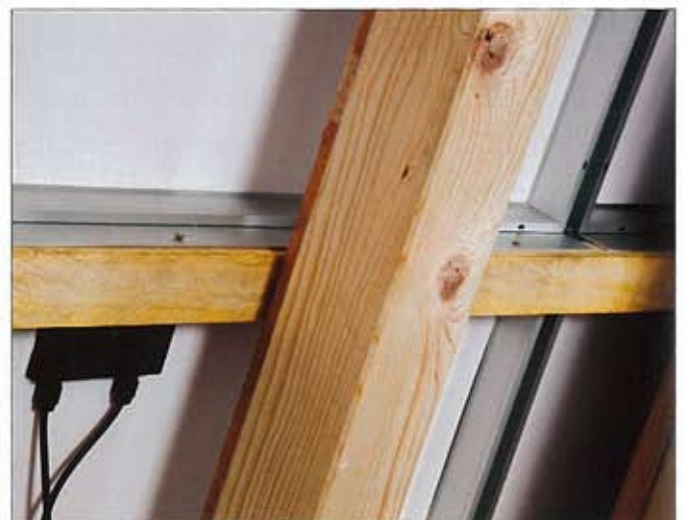
Durch einen speziellen Rahmen mit integrierten Bohrlöchern kann dieses Modul direkt auf die Dachlattung geschraubt werden. Dadurch liegt es tief im Dach, und der Montageaufwand ist gering. Rechts: Blick von innen
