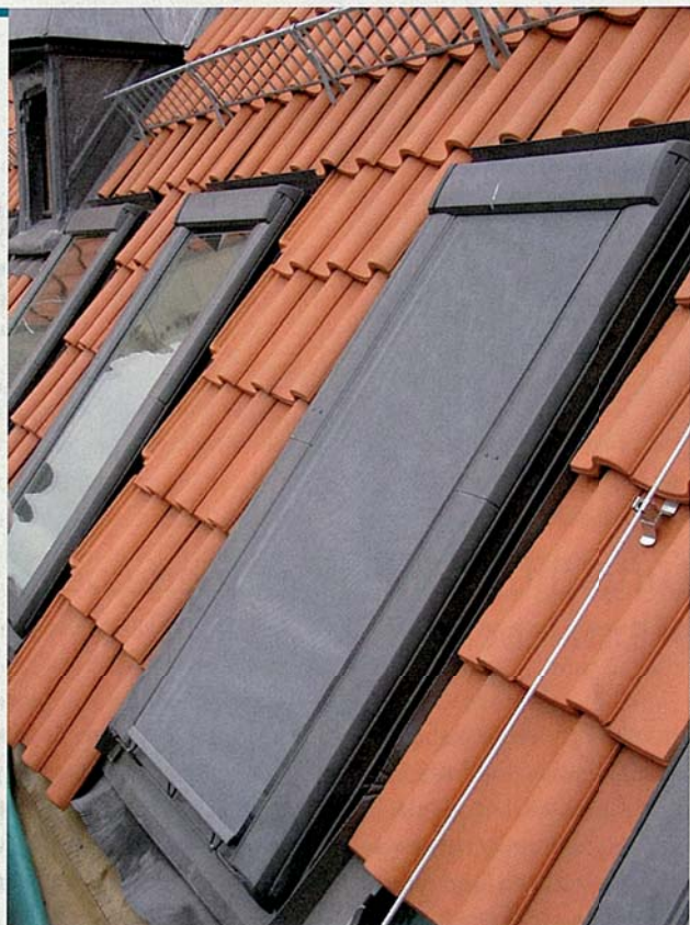
Eine lichtdurchlässige Markise aus Glasfasergewebe sorgt für Blendschutz und trägt zum Schutz vor sommerlicher Überhitzung bei.
