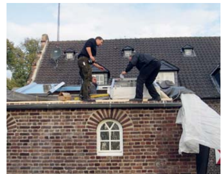
▲ Stapelspeicher und Eindeckrahmen mussten mit dem Kranwagen transportiert werden
