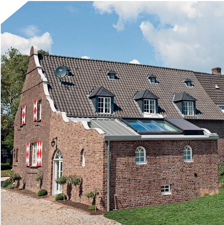
▲ Der kleine Anbau wurde früher als Geräteschuppen genutzt. Für den Einbau des Panoramafensters musste die Dachneigung teilweise von 10 auf 25 Grad erhöht werden
