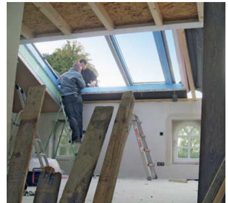
▲ Die exakte Ausrichtung des Blendrahmens erforderte sorgfältige Arbeit
