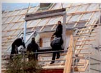
▲ Der große Blendrahmen wird mit Hilfe des Autokrans in die Einbauöffnung bugsiiert
