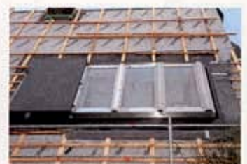
▲ Nach rund vier Stunden war das Panorama-Fenster inklusive Eindeckrahmen eingebaut
