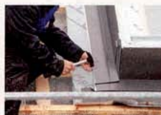
▲ Befestigung eines Eindeckrahmenblechs mit Wasserablauf- rinne am Stapelspeicher
