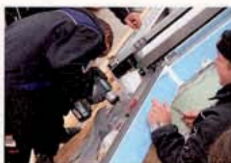
▲ Der Rahmen wird an einer Latte befestigt, die unterhalb der Dachöffnung montiert ist
