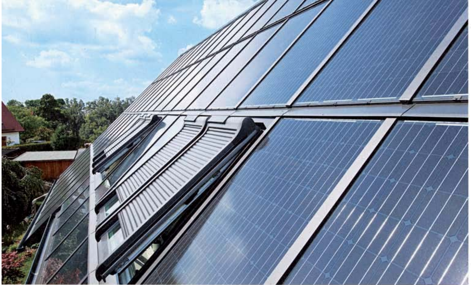
▲ Die südliche Dachfläche versahen die Dachdecker bis auf die vier Dachflächenfenster komplett mit Solarmodulen
