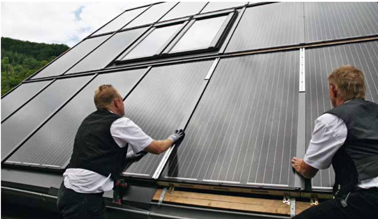
Roto Sunroof Montage der Elementabdeckungen
