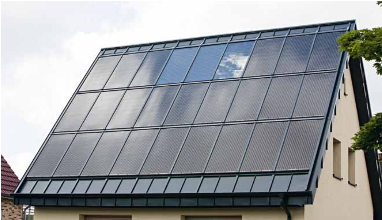
Roto Sunroof Kombination aus PV-Modulen und Solarkollektoren
