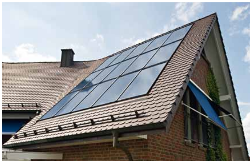
Wohnhaus in Vechta Solaranlage 19,08 m 2 zur Trinkwassererwärmung und Heizungsunterstützung in Kombination mit 5,7 kWp Photovoltaik
