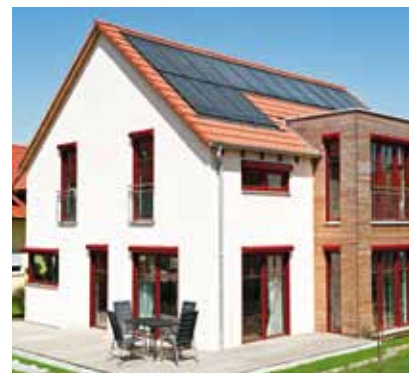
Wohnhaus in Nandlstadt Photovoltaik-Anlage 3,2 kWp zur Stromerzeugung in Kombination mit Solaranlage 10,6 m 2 zur Trinkwassererwärmung und Heizungsunterstützung
