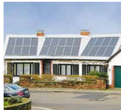
Mehrfamilienhaus in Saarbrücken Photovoltaik-Anlage 7,02 kWp zur Stromerzeugung
