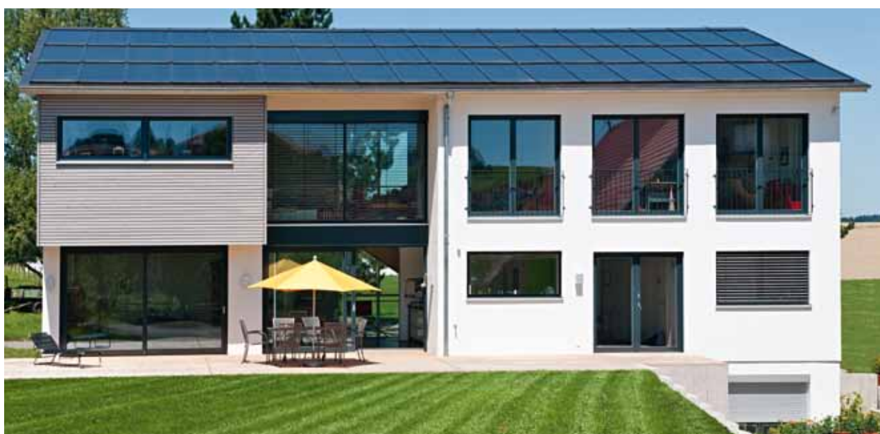
Wohnhaus in Hechingen Solaranlage mit 14,5 kWp Photovoltaik
