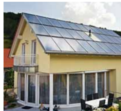
Einfamilienhaus in Bad Mergentheim Photovoltaik-Anlage 8,7 kWp zur Stromerzeugung
