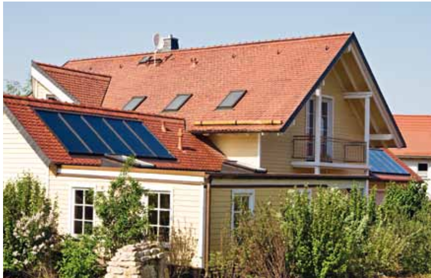
Wohnhaus in Dingelstedt Solaranlage 21,2 m 2 (Ausschnitt) zur Trinkwassererwärmung, Heizungsunterstützung und Schwimmbaderwärmung
