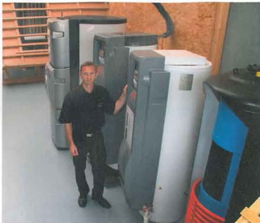
Die Solarspeicher sind so weit vormontiert, dass der Handwerker nur noch die wasserseitigen Anschlüsse installieren muss, wie Daniel Erbert erklärt.
